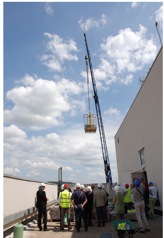
Rénovation des terrasses de la cité administrative de Tulle en juin 2014
